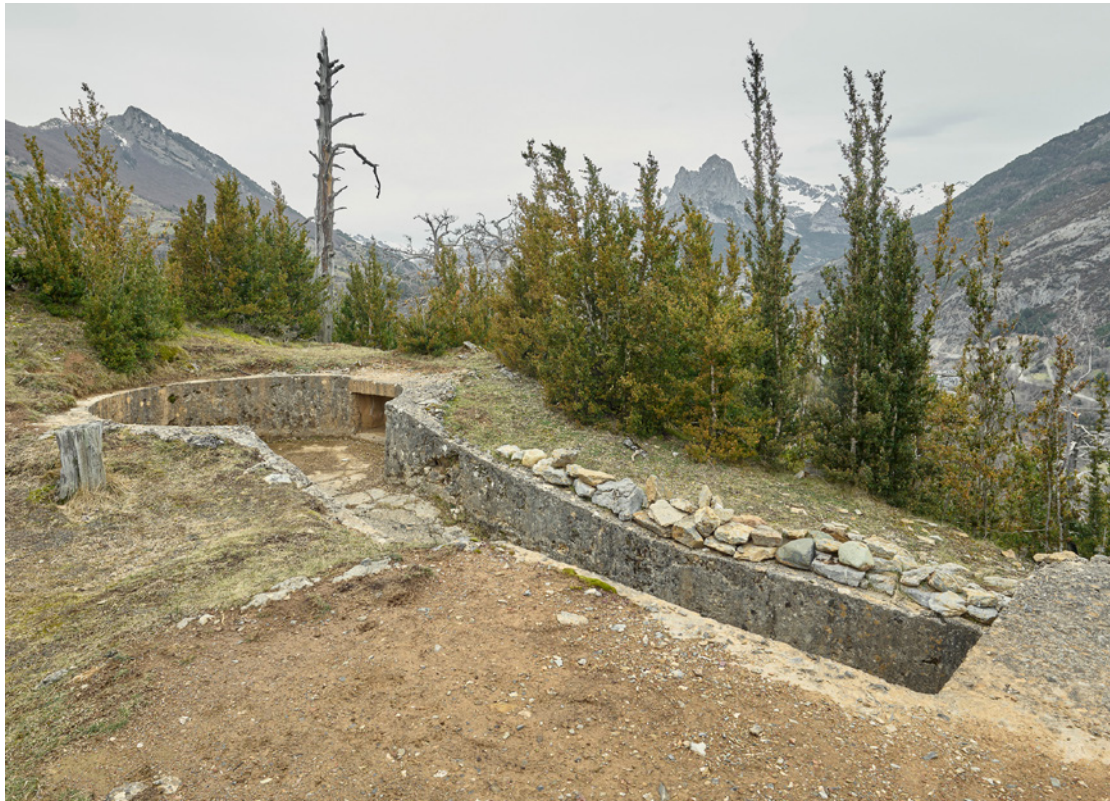
NR 108 Las Grampas, Obra 40, Ametralladora antiaérea 20 mm. Coord. 42.74725, -0.31135. Alt. 1.437 m. 24/2/2025. © Iñaki Bergera
