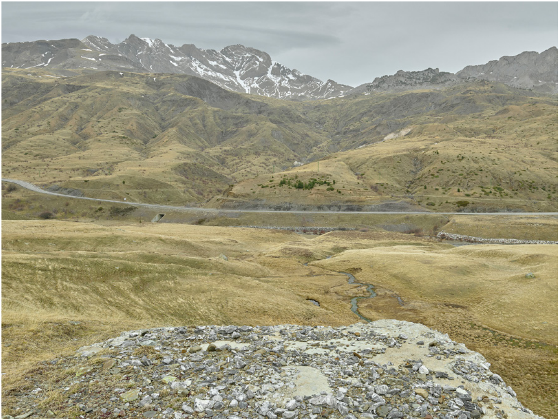
NR 110 El Furco, Obra 41, Fusil Ametrallador. Coord. 42.77409, -0.38157. Alt. 1.572 m. 8/3/2024. © Iñaki Bergera
